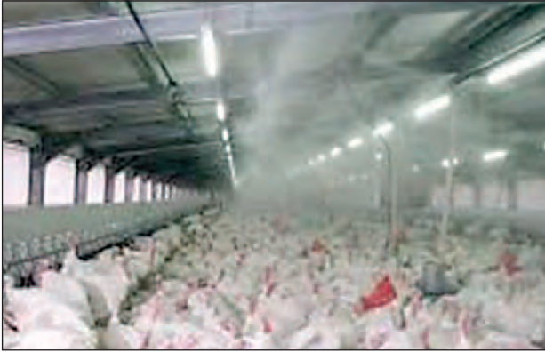
Fig. 7.11 : Fogger system
