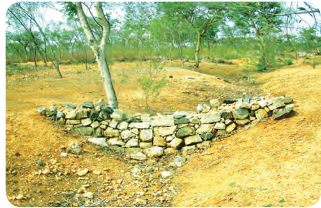
Fig. 6.9 : Gully plug
